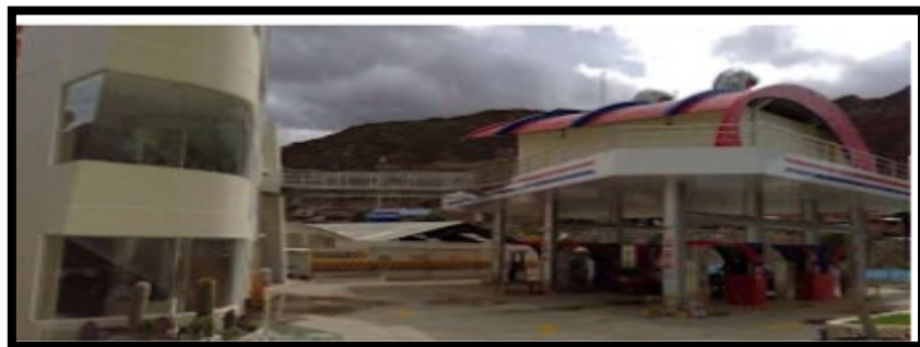
Figura 6. Frontis de la Estación de Servicio
